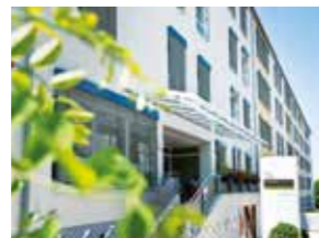
Haus Caspar Bietigheim-Bissingen
