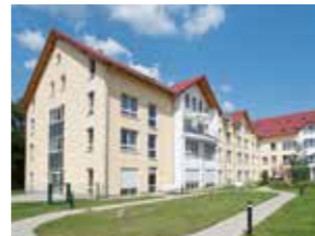
Haus Dominic Elsenfeld
