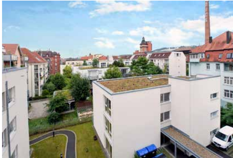
Aus dem einstigen Wohnbereich „Dicker Turm“ im Seniorendomizil Haus Melchior in Esslingen wurde Wohnraum für Mitarbeiter.
