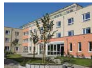
Haus Sibylla Muggensturm
